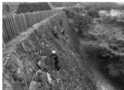
近接目視・打音検査
