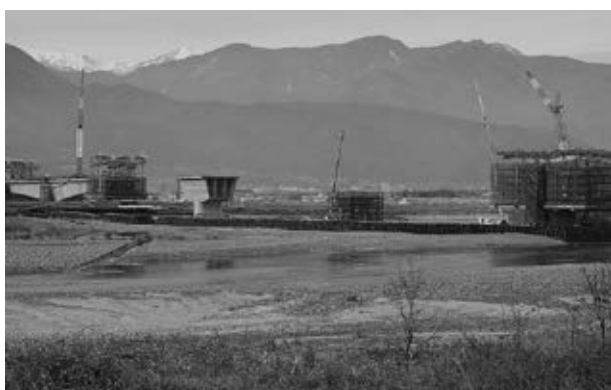
釜無川のリニア橋桁工事
