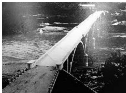
ほぼ完成した小倉橋。橋の途中に自動車がすれ違うための退避場所が設けられています。現在も当時のまま。自動車で渡る場合、対向車が渡りきるまで橋の手前で停止して待つのが暗黙のルールとなっています。
