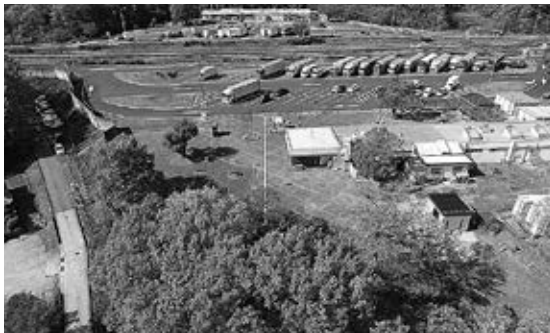
社パーキングエリア(下り線側) 中央の白線が子午線です！※残念ながら、グーグルアースでは工事中の画像です。完成後の画像に更新されることを待つことにします。
