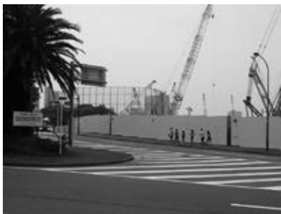
建設現場の様子B
