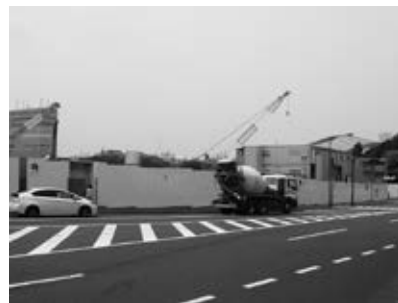
建設現場の様子C
