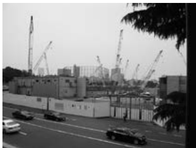
建設現場の様子A
