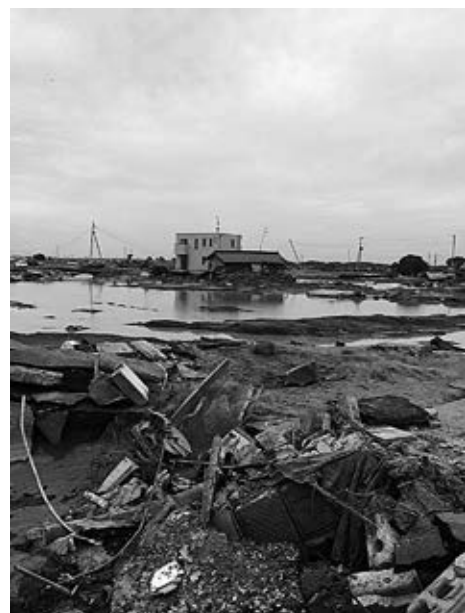
鬼怒川堤防決壊付近を撮影
