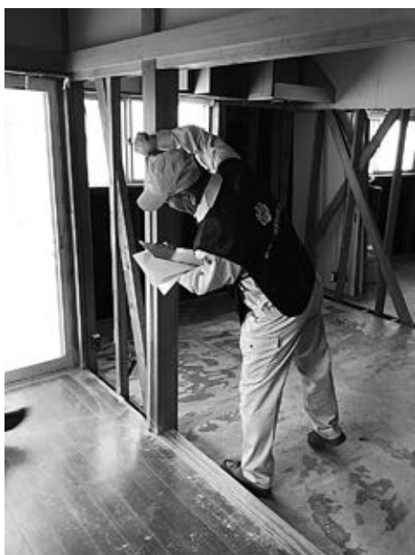
被害認定調査の様子(浸水高を測定中)
