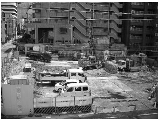
基礎工事時には規約完成
