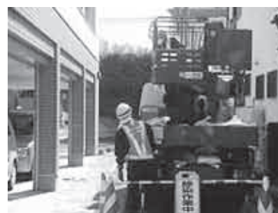
外壁除染(福島会館)
