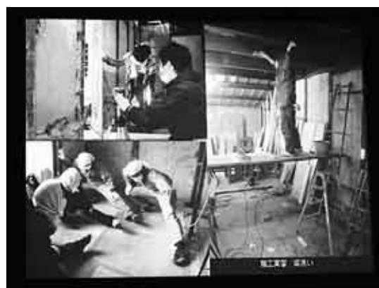
長屋住宅再生プロジェクト風景(大阪市立大学)
