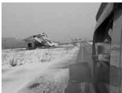
津波で倒壊したままの家屋
