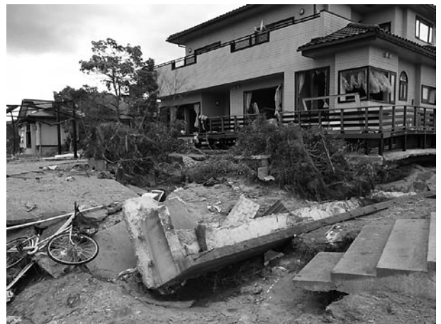
津波により被災した会員宅
