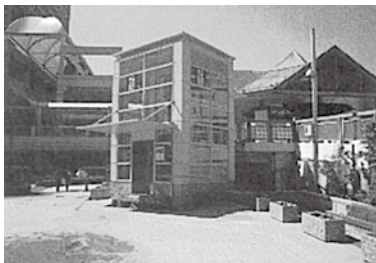
駅前エレベーターの飛出し
