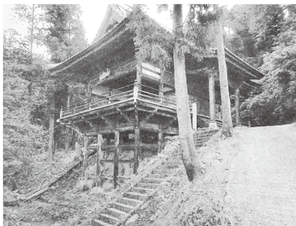
如法寺観音堂の急傾斜な石段
