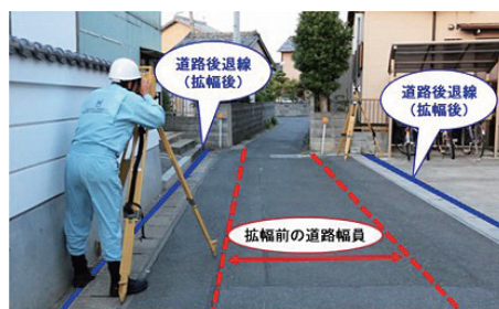
fig. 5 完成後の境界復元作業
